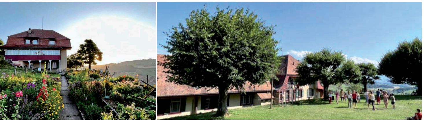
Haus in Walkringen
